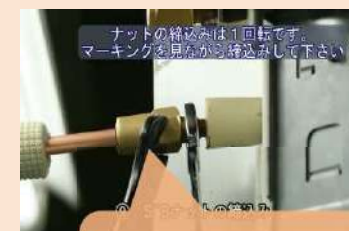
ネジ接合継手 施工要領動画
